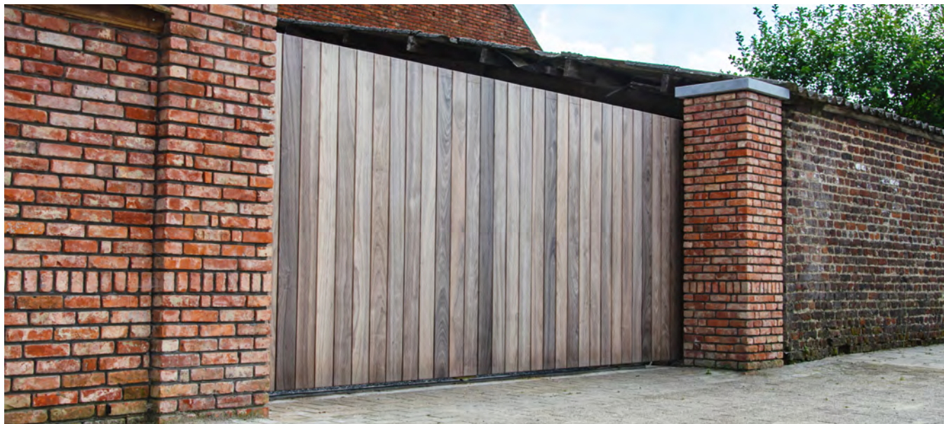
Schuifpoort planketten verticaal
