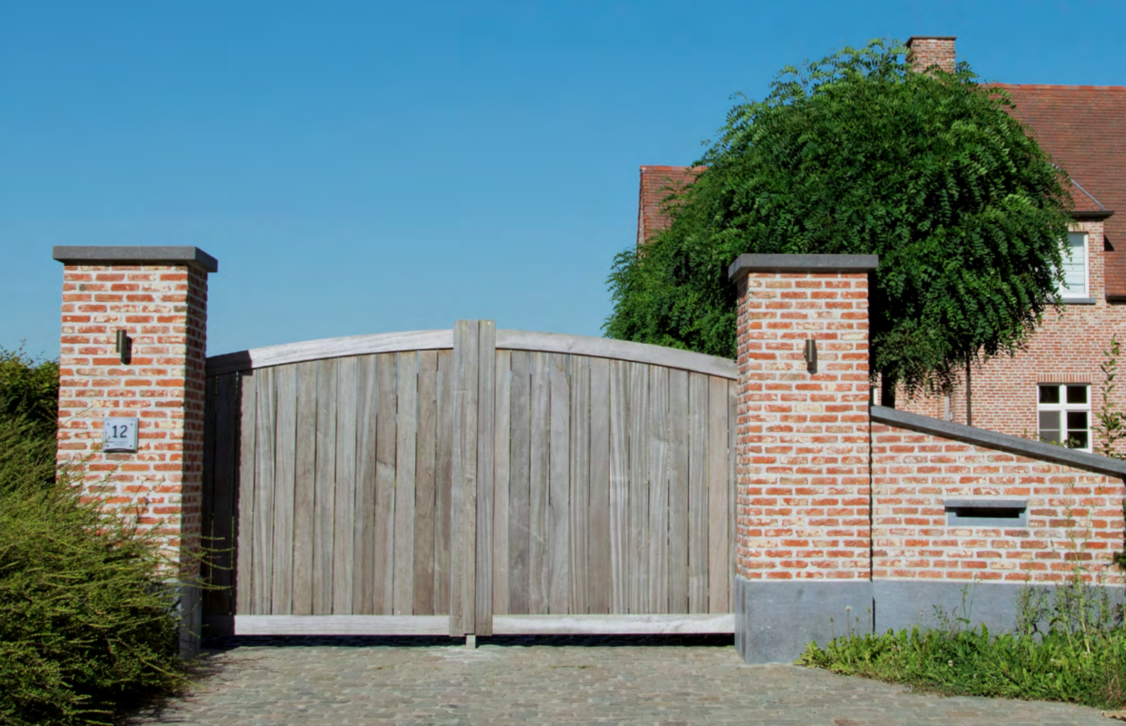
180/200 x 300 cm padouk; geautomatiseerde poort; daardoor zonder klink en slot.
