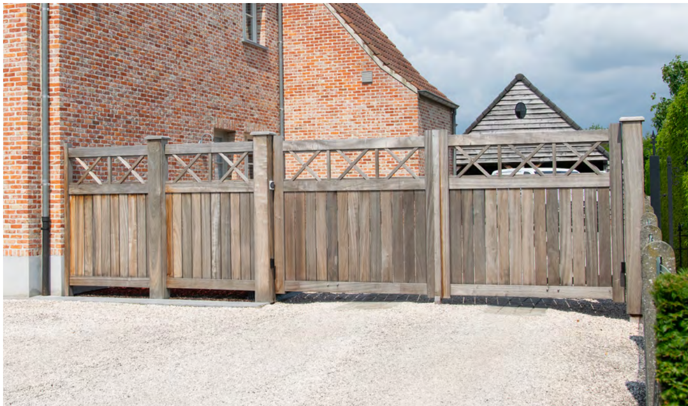
180 x 300 cm met zuilen in padouk en 2 vaste panelen maatwerk
