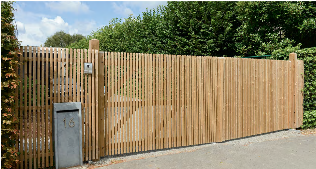
Patio vertikaal grenen, op maat gemaakt
